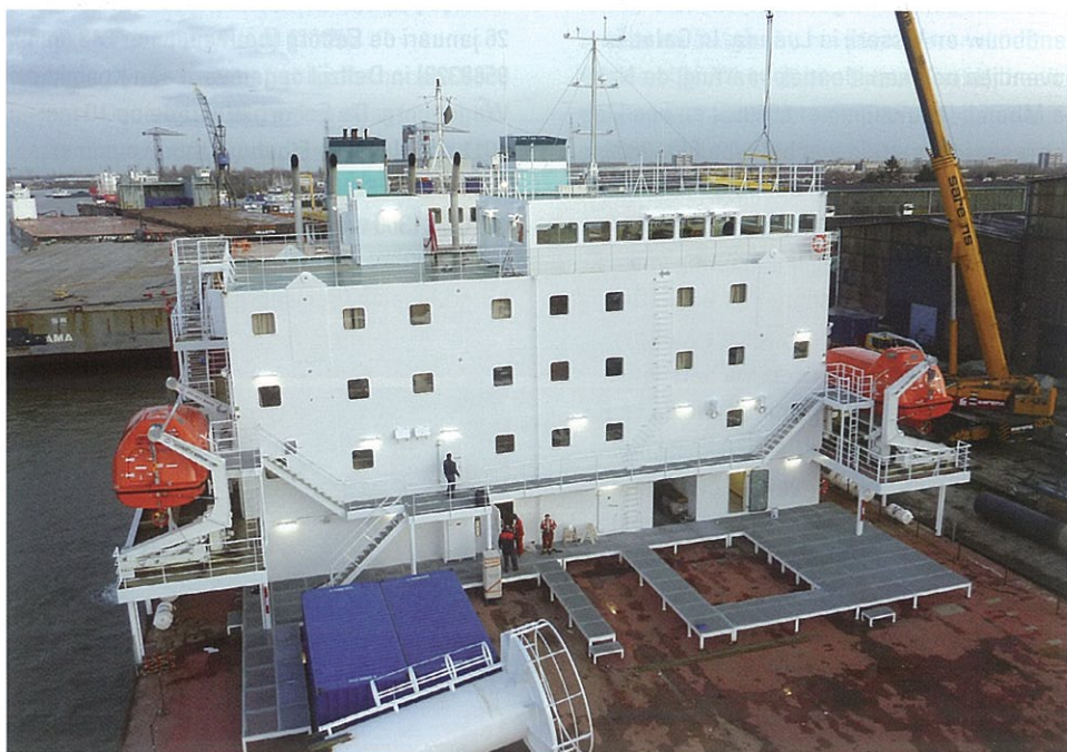
De SBBA na installatie op de Cable Enterprise
