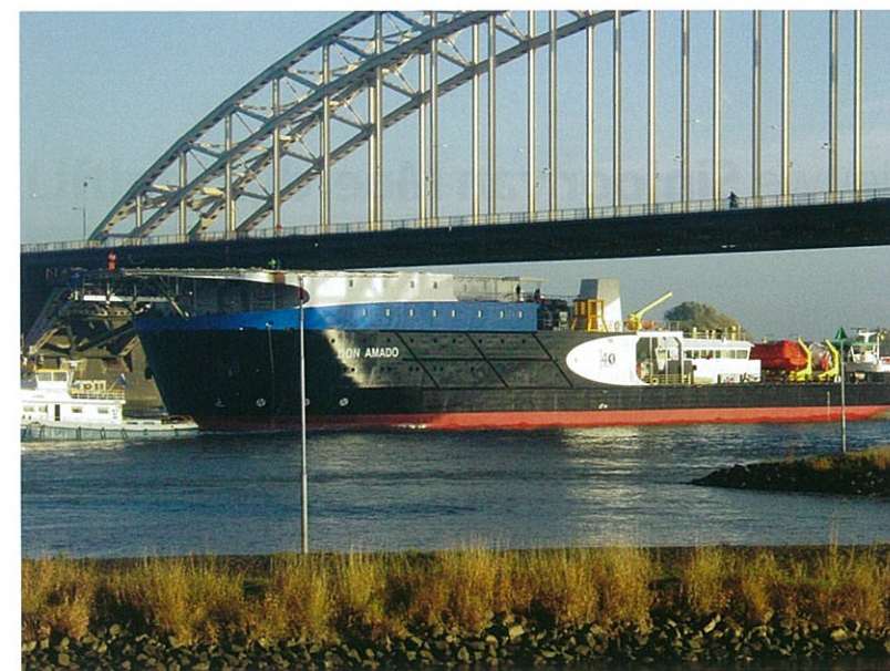
▲ THE RELOCATION OF THE ENTIRE PRODUCT FROM LOBITH TO ROTTERDAM. AN ALMOST MILITARY OPERATION ▲ DE VERHUIZING VAN HET COMPLETE PRODUCT VAN LOBITH NAAR ROTTERDAM. EEN BIJNA MILITAIRE OPERATIE.
